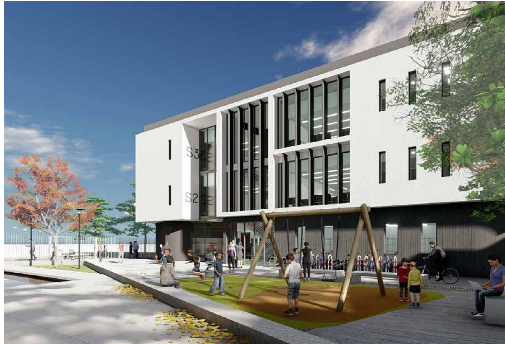
Vista de la fachada principal y norte desde la plaza pública que enfrenta el proyecto. Esta plaza alberga lugares de permanencia para el disfrute de las personas a las esperas de sus consultas.
