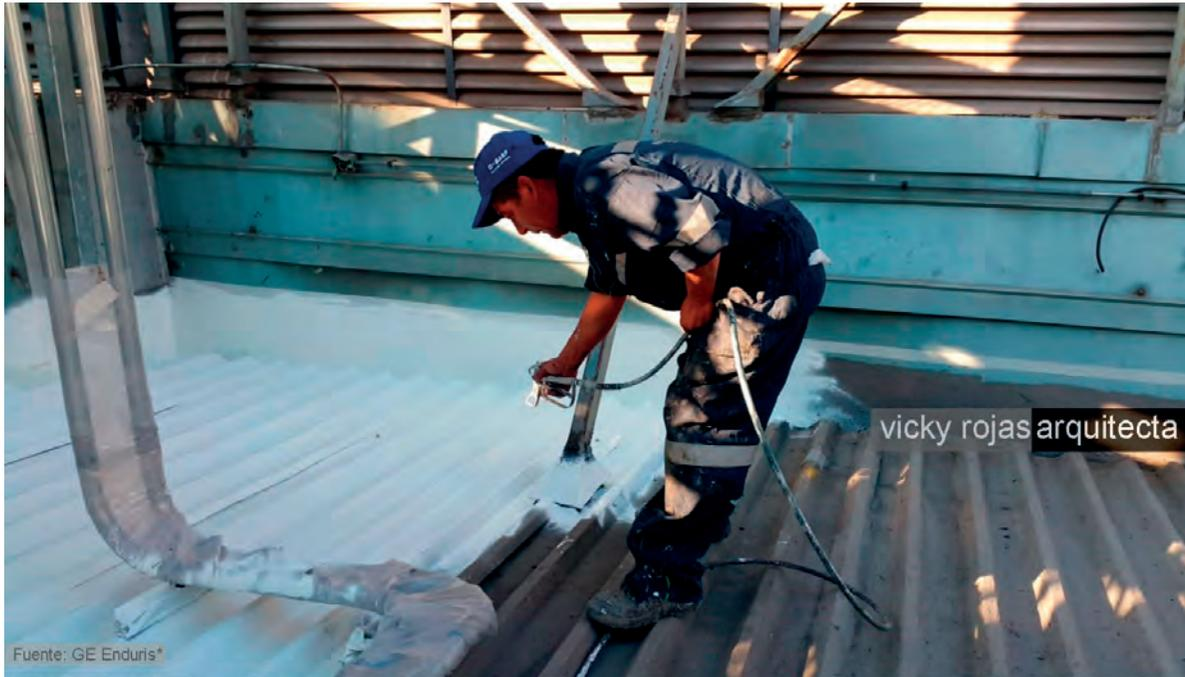
**FOTOGRAFÍA DE RECUPERACIÓN DE CUBIERTA ANTIGUA CON GE ENDURIS RECUBRIMIENTO DE SILICÓN PARA TECHOS**
